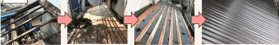
建物と屋根の間に隙間がありますね。「置き屋根」という工法で、屋根の下にもう一つ土の屋根があります。
