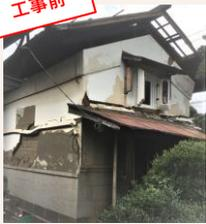
雨水が壁に入り、土壁の剥がれと壁の膨らみが出てしまっていました。剥がれた箇所は丁寧に補修し、新たな壁を作っていきます。
